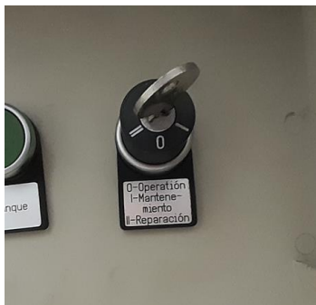
Llave seleccionando estado: I – Mantenimiento. Key status in: I-Mantenimiento
